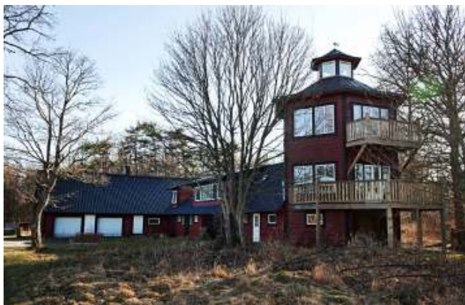
OMBYGGT. Den tvåhundra år gamla ladan har byggts om för möten och boende.
